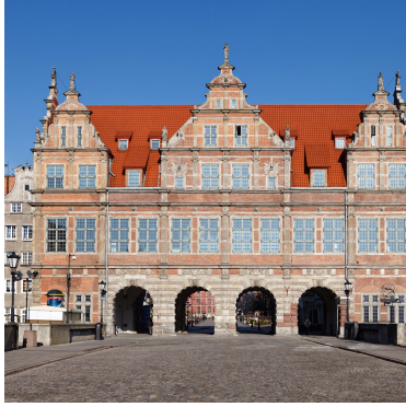
Zielona Brama 1,5 km od Montowni
