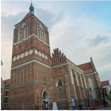
Kościół Św. Jana 1,2 km od Montowni
