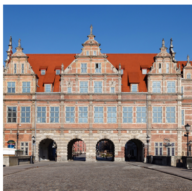
Zielona Brama 1,5 m od Montowni
